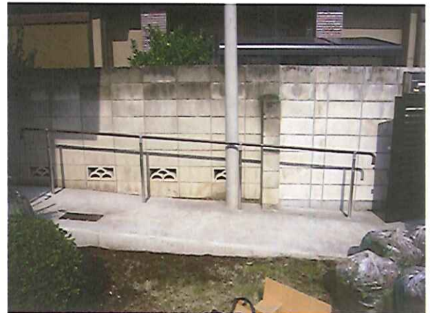
転倒防止手すり・スロープの取り付け
