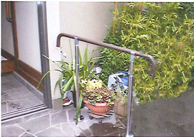
転倒防止手すり・スロープの取り付け
